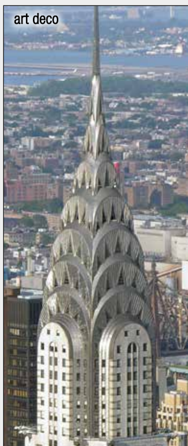
▲ Vrcholová část věže mrakodrapu Chrysler Building (New York, USA)
